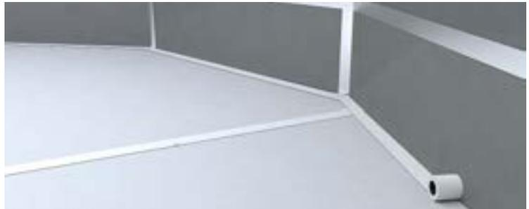
Successivamente, posizionare bene i vari pezzi di feltro sul fondo, uno contro l'altro senza sovrapporli. Unire le varie parti con l'utilizzo di nastro adesivo. Applicare il nastro adesivo anche nei punti dove il feltro si unisce alle pareti in acciaio.
