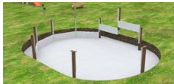
Per ottenere i punti su cui installare i sostegni intermedi tra **C/D** e **E/F**, inserire 2 pannelli della struttura di base.
