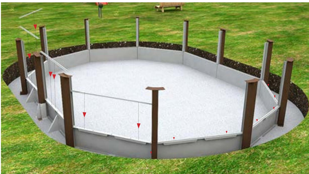
Procedere con il fissaggio dei profili utilizzando i buchi preforati realizzati per questo scopo. Ripetere l'operazione su tutto il perimetro della piscina.
