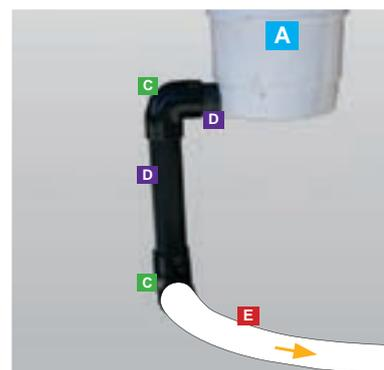
Per completare il collegamento dello skimmer, tagliare un tubo di PVC rigido di circa 7 cm per collegare l'uscita dello skimmer al gomito 90°.
