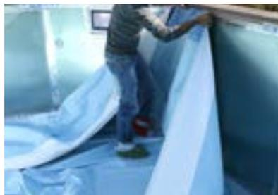
Inserire orizzontalmente l'aggancio superiore del liner nel profilo superiore in pvc, che rimarrà agganciato automaticamente.
