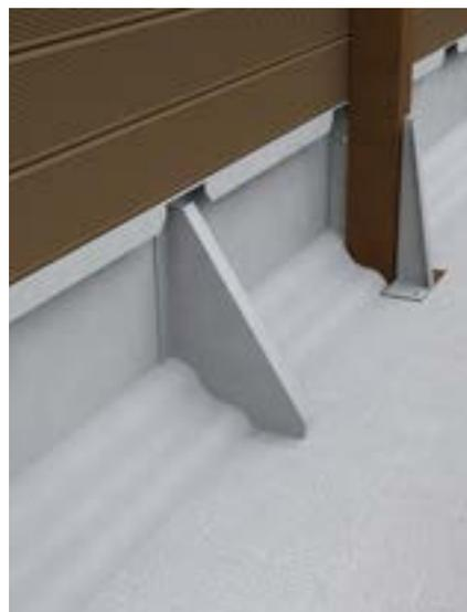
Prima di iniziare con il terrapieno si raccomanda la realizzazione di una cintura di cemento su tutto il perimetro di un'altezza di 15 cm, per evitare la presenza d'acqua tra il liner e la struttura.
