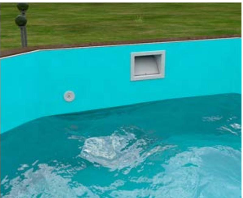
Un volte che le flange dello skimfilter e della bocchetta sono state posizionate e avvitate, posizionare anche il resto dei pezzi che compongono gli accessori come nella figura.
