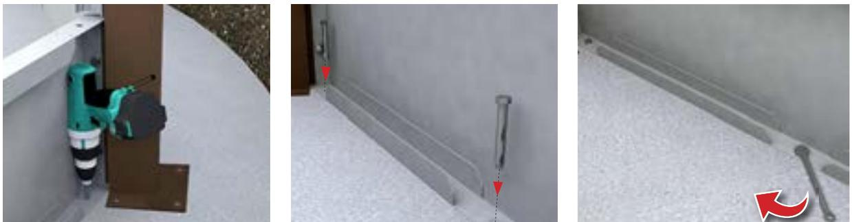
Utilizzare il metodo precedente anche per la struttura. Fissare i pannelli della struttura di base alla soletta di cemento.
