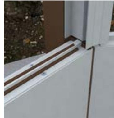
La traversa che formerà la prima fila è la numero 1, e si inserisce direttamente sul profilo di alluminio dopo aver applicato un cordone di silicone.
