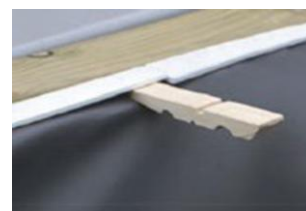
Figure 28 - Verrouillage du liner grâce à des demi épingles à linge
