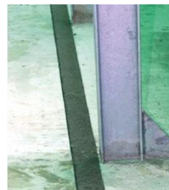
Figure 7 - Mise en place des bandes bitumineuses
