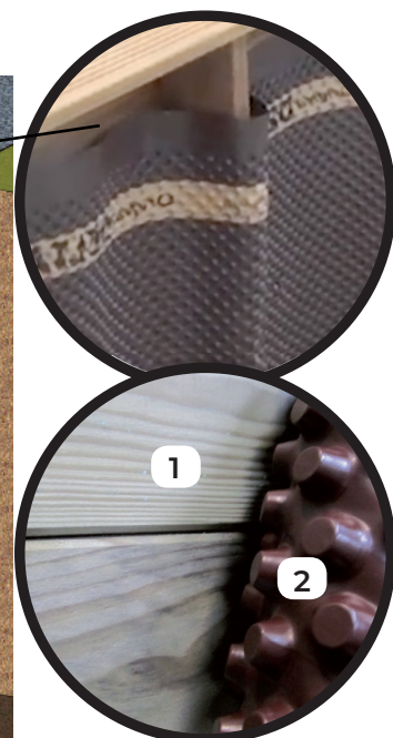
1- Struttura in composito 2- Rotolo protettivo e drenante alveolare in PEHD
