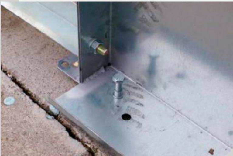
■ Mediante l'avvitamento nella bussola di una vite opzionale 10x55 mm è possibile regolare perfettamente il livello del singolo pannello e di conseguenza dell'intera struttura, ottimizzando i tempi di installazione ed evitando l'utilizzo di materiali impropri che potrebbero causare modifiche accidentali di livello. La regolazione massima consentita è di 4 cm: in caso di maggiori dislivelli occorrono viti più lunghe o barre filettate.
