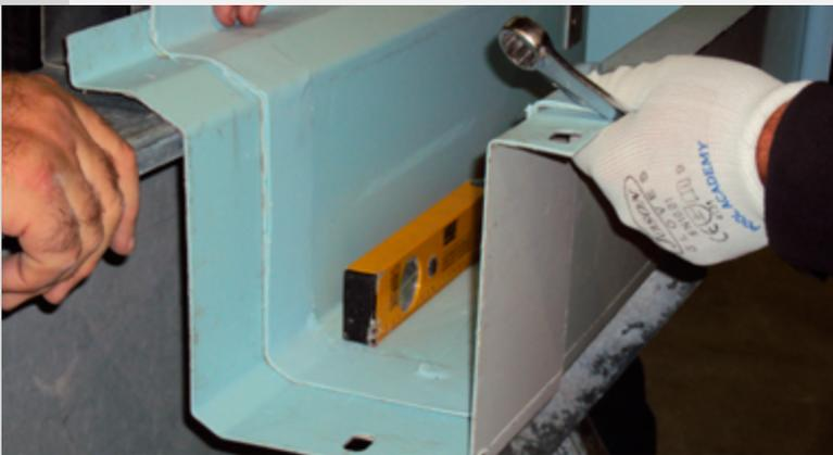
4. provvedere a posizionare le giunzioni sotto il canale assicurandosi che rimanga il livello adeguato
