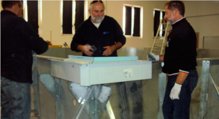
2. fissare il bordo sfioratore al pannello e alla squadra con rivetti inox 4,8x20 mm (eseguire fori diametro 5 in opera)
