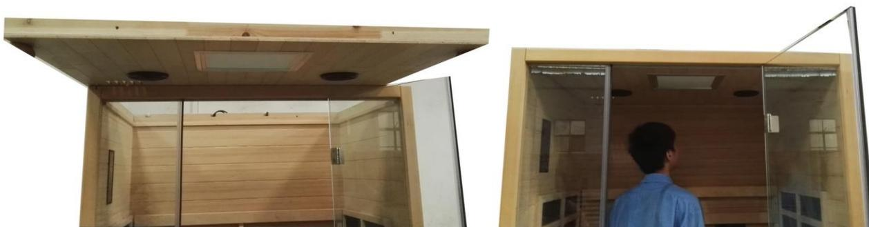
Abbassare il pannello del tetto sui pannelli assemblati.
