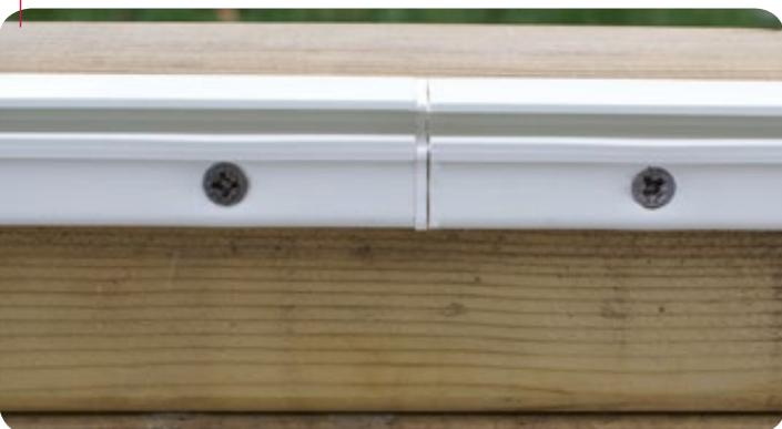
Verso la fine sarà necessario tagliare le lunghezze. Tagliare le lunghezze a dimensione tra due giunzioni di profili di fissaggio poi piegare i profili per permettere ai perni di giunzione di adattarsi in posizione.
