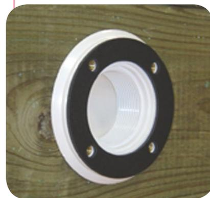
▶ Lavorando dall'interno della piscina, adattare le 3 flange a parete (imballo Montaggio Piscina) per i 2 raccordi di ritorno e pulire il punto in cui pre-forate le aperture. Fissarle insieme in posizione usando una vite intagliata in legno con svasatura (VB FZ).
