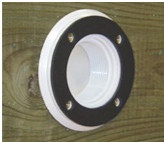
Figure 24 – Montage du corps de la buse de refoulement et de son joint
