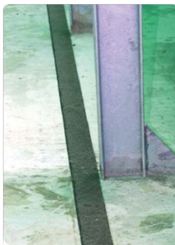
Figure 7 – Mise en place des bandes bitumeuses
