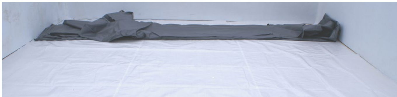
Figura 27 – Despliegue del revestimiento
