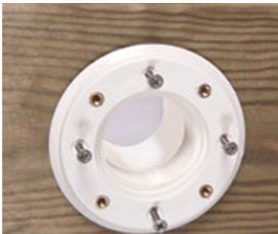
Figure 24 – Montage du corps de la buse de refoulement et de son joint
