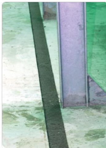
Figura 7 – Instalación de las bandas bituminosas
