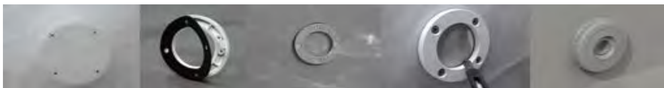
Figura 36 - Installazione della flangia del raccordo di ritorno
