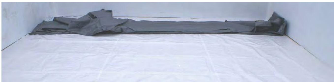
Figura 34 - Dispiegamento del liner
