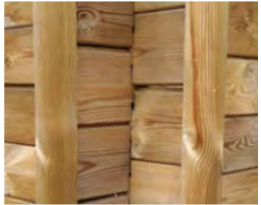
Figura 62 – Incastro delle doghe in legno
