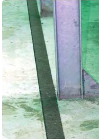
Figura 9 – Posa delle strisce bituminose
