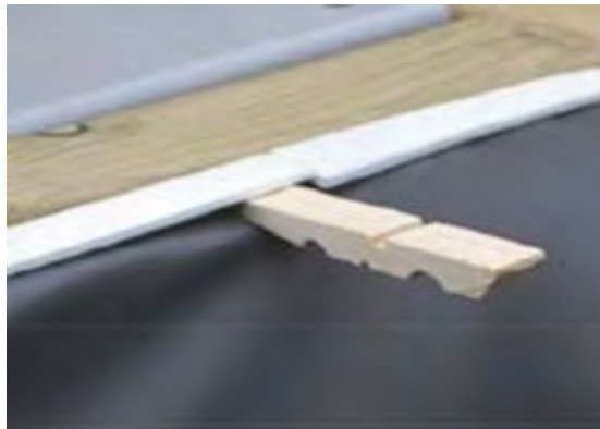
Figura 33 - Bloccaggio del liner in posizione con mezze mollette
