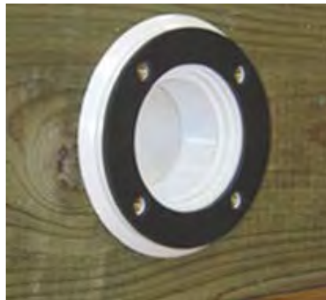
Figura 26 - Montaggio del corpo del raccordo di ritorno e della guarnizione
