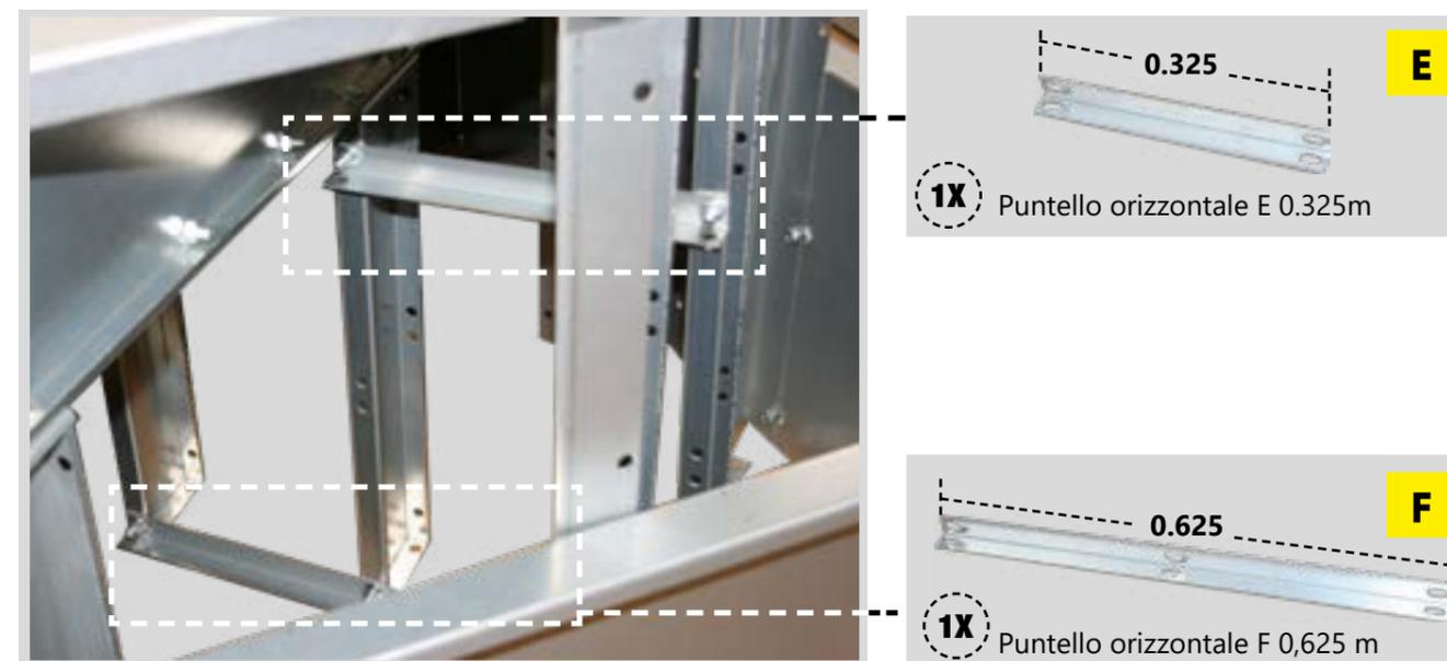
**15** Posizionamento dei puntelli orizzontali E ed F fissati ai puntelli verticali A, B e D ed eventualmente regolati. Questi puntelli devono essere immersi nel cemento con un'altezza minima di 0,20 m.
