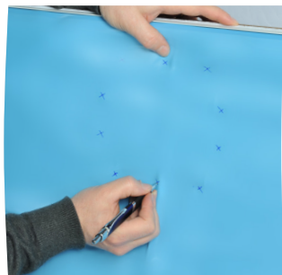
Repérez et tracez l'emplacement des vis
