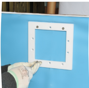
Aparafuse o flange e aligeire o liner
