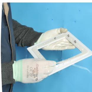
Coloque a junta sobre o flange
