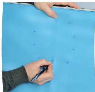
Localice y señale la ubicación de los tornillos
