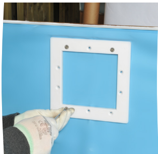
Avvitare il traversino e togliere il liner
