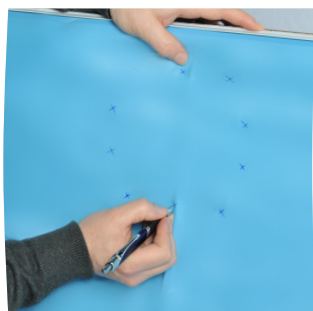
Localize e assinale a localização dos parafusos
