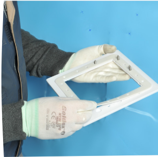
Plaats het verbindingsdeel op de flens
