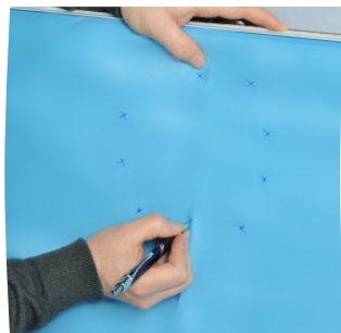
Individuare e segnalare la posizione delle viti
