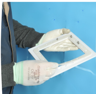
Posizionare il giunto sopra il traversino
