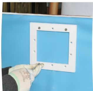
Atornille la brida y ahueque el liner
