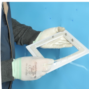
Coloque la junta sobre la brida
