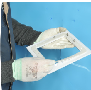
Posizionare il giunto sopra il traversino
