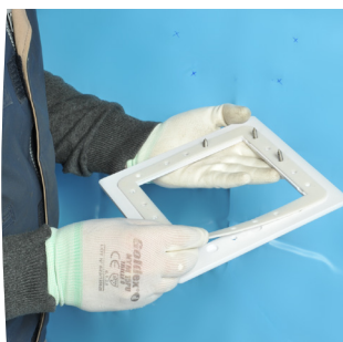
Coloque a junta sobre o flange
