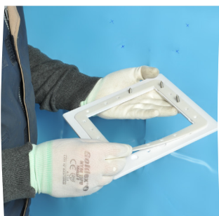
Setzen Sie die Dichtung auf den Flansch
