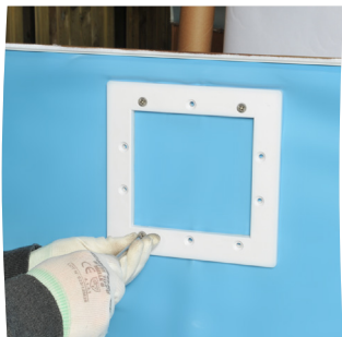
Aparafuse o flange e aligeire o liner
