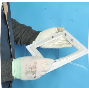
Coloque la junta sobre la brida
