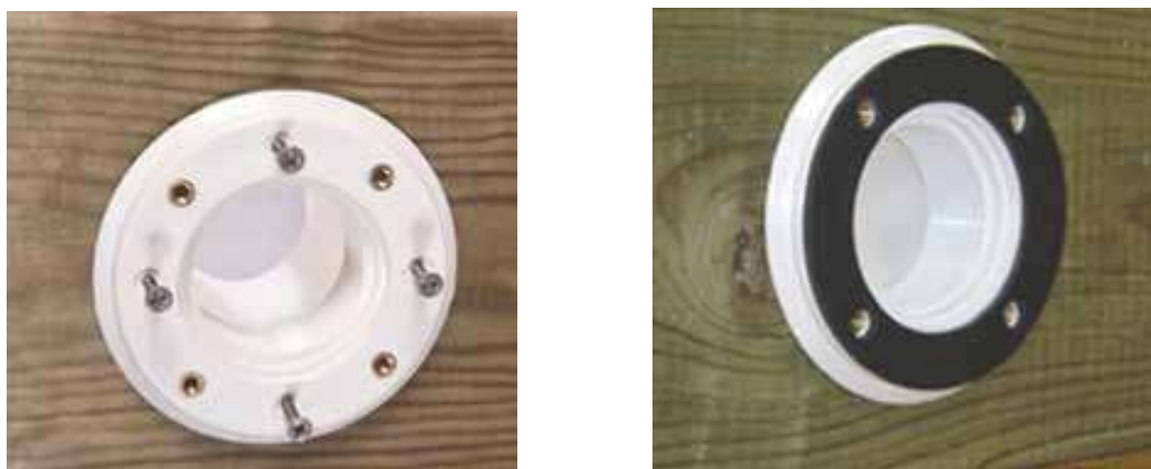
Figura 26 – Montaggio del corpo della bocchetta e della relativa guarnizione
