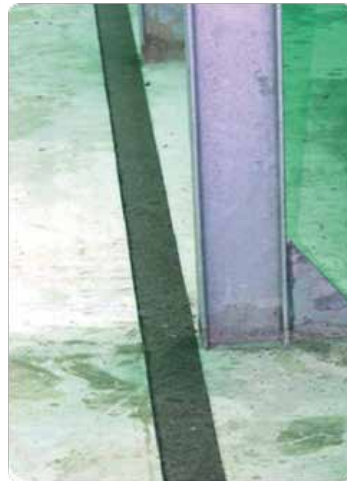
Figura 9 – Posizionamento delle bande bituminose
