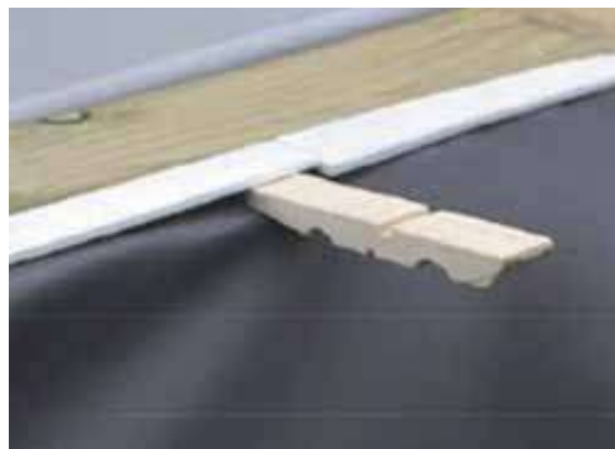
Figura 33 – Blocco del liner mediante semi-mollette per bucato
