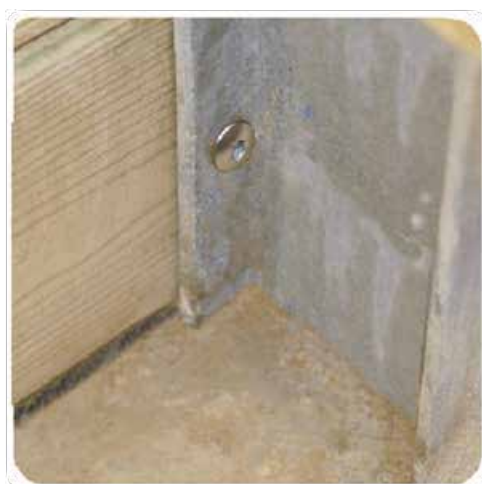
Figura 13 – Blocco delle assi sui pali di fondazione
