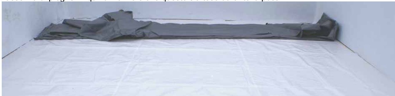
Figura 34 – Dispiegamento del liner
