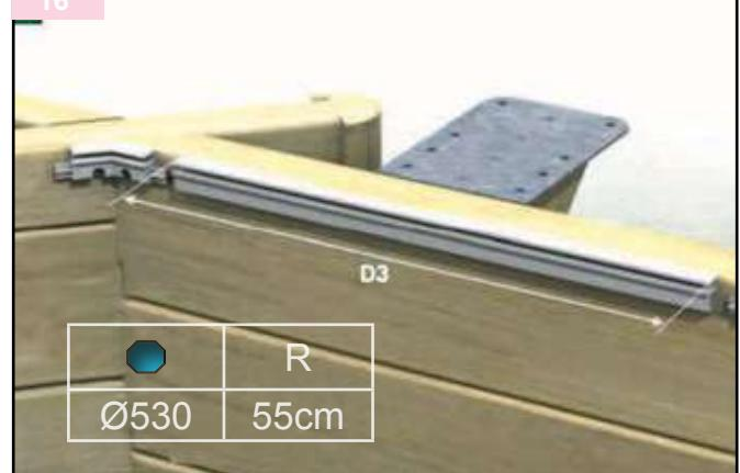
Posizionate e fissate a ogni angolo della piscina i giunti angolari (blister giunzioni+angoli) utilizzando 2 viti inox (sacchetto E) negli appositi incavi. Assicuratevi che i pezzi siano perfettamente a filo con la parte superiore della parete. Ogni lato della parete ospita un binario di lunghezza 1,18 m + una lunghezza complementare da tagliare.
