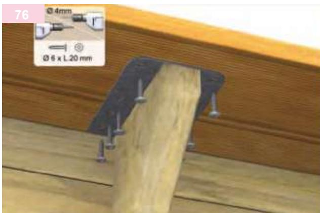
Fissare le tavole sulle piastre metalliche dei supporti (mensole) utilizzando le viti per cardini (sacchetto G o H), avvitando dal basso come indicato. Effettuare una leggera pre-foratura per facilitare l'inserimento. Controllare costantemente il corretto allineamento dell'insieme.
