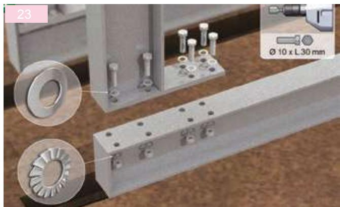
Avvicinate al bordo degli scavi gli elementi che compongono i supporti (basamenti) e assemblateli (utilizzando il kit piastre per supporti).
