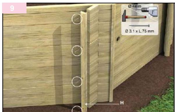
Prima di posare i profili di finitura, è necessario installare un rinforzo in ogni angolo.
