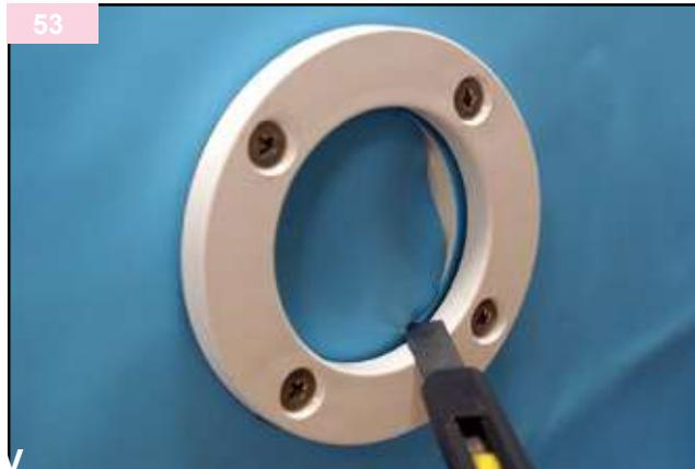
Effettuate il taglio del rivestimento in corrispondenza della bocchetta di mandata. Aiutandovi con un cutter, tagliate accuratamente il liner appoggiandovi al profilo interno del corpo della bocchetta.
