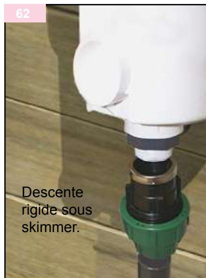
Avvitate sotto lo skimmer il raccordo J, non dimenticando di applicare il teflon su entrambe le filettature.
