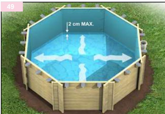
Quando il liner è perfettamente agganciato e in posizione, riempite la piscina con soli 2 centimetri d'acqua. Spingete il più possibile le pieghe del liner dal centro verso le pareti. Controllare il tutto .
