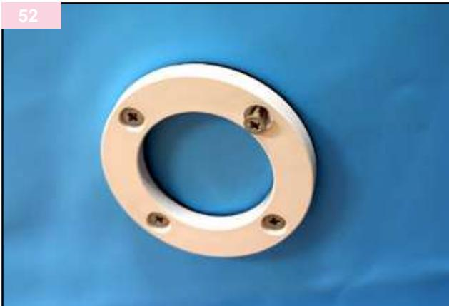
Effettuate l'avvitamento della flangia, completa della sua guarnizione adesiva, utilizzando le viti in acciaio inox FZ M5x16 in dotazione con il pezzo da murare. Durante questa operazione, assicuratevi di effettuare un serraggio alternato per garantire una perfetta tenuta stagna. Prediligete un serraggio manuale per evitare una pressione troppo brusca che rischierebbe di incrinare la flangia.
