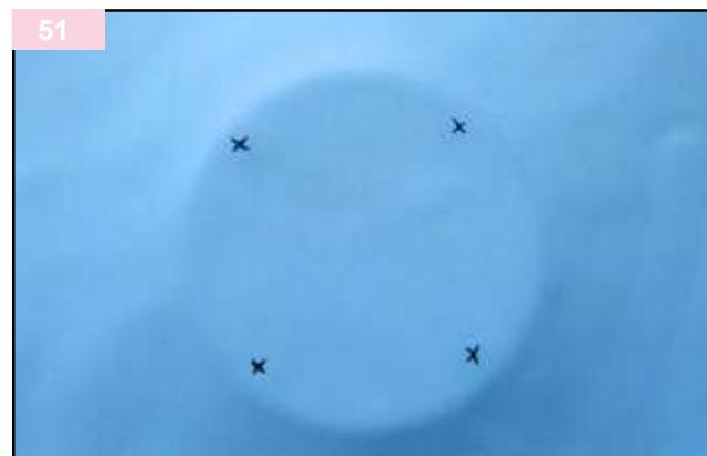
Individuate attraverso il liner i quattro punti di avvitamento del corpo della bocchetta.
