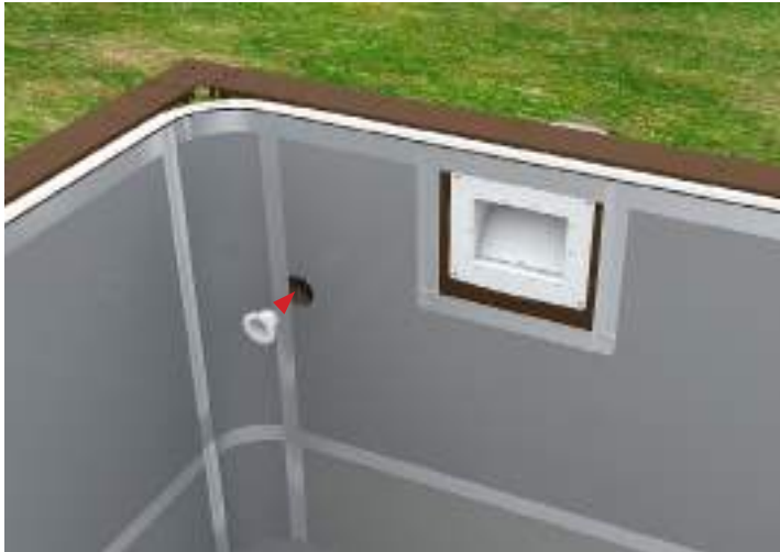
L'ugello di scarico viene posizionato sulla perforazione
