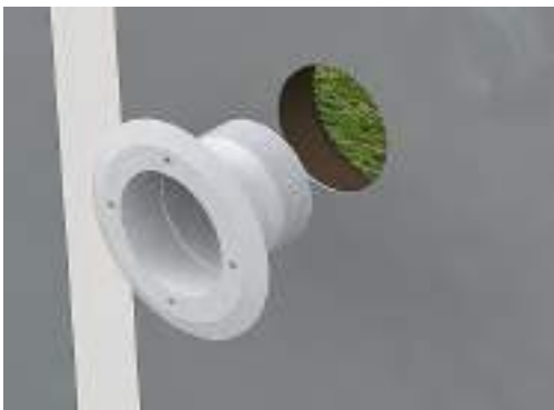
L'ugello di scarico viene posizionato sulla perforazione
