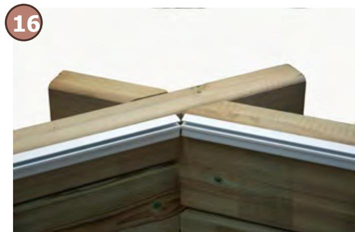
Ogni lato della piscina è montato con un tracciato di 1.18 m di lunghezza e un altro tracciato rifilato per il montaggio, vedi la tabella sotto. Rifilare 8 tracciati in base alla tabella sotto. Prima di fare i tagli, controllare che la lunghezza totale del tracciato sia uguale alla lunghezza del parete meno 10 cm. Usare un metro per assicurarsi che i tagli siano puliti e dritti. Rifilare i tagli usando una lima a grana fine.
