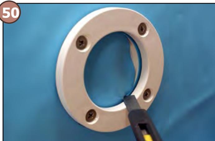
Tagliare il liner all'interno della presa di aspirazione e all'interno della flange delle bocchette di emissione.
