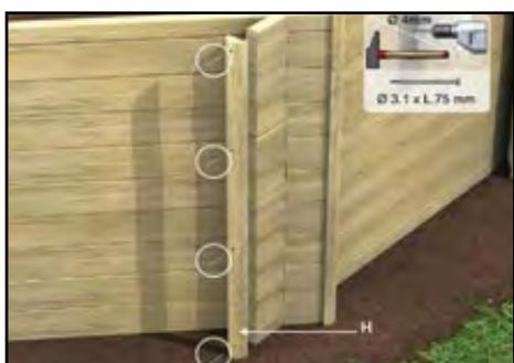
Montare il profilo decorativo (tipo H) alla fine di ciascuna parete usando i chiodi (3.1 x 75 mm) inseriti attraverso fori equamente separati e pre-forati lungo le assi del profilo.
