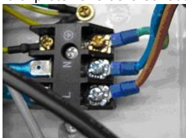
Figura 9: Morsetti di collegamento alla rete elettrica.
