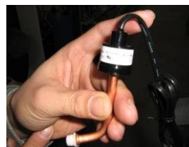
Figura 45: Pressostato di minima.
