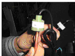
Figura 44: Pressostato di massima.
