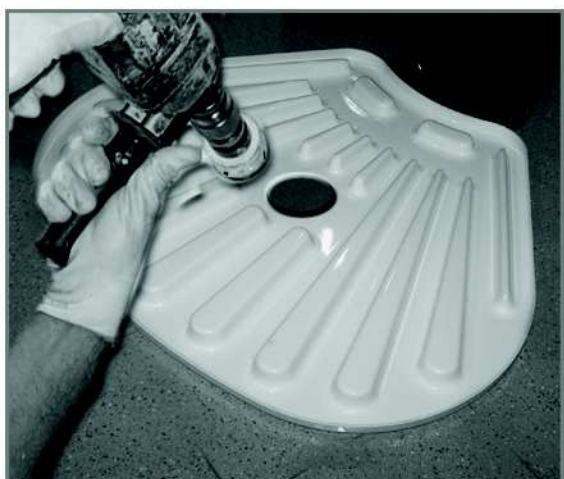
03 Forare la base in corrispondenza dello scarico
